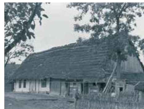
Czarna (pow. bieszczadzki), chałta zrębową z dachem dwusпадowym z przydaszkami, jednotraktowa, jednoizbowa. Od południa ogródek otoczony plecionym pionowo płotem; fot. 1957 r.
