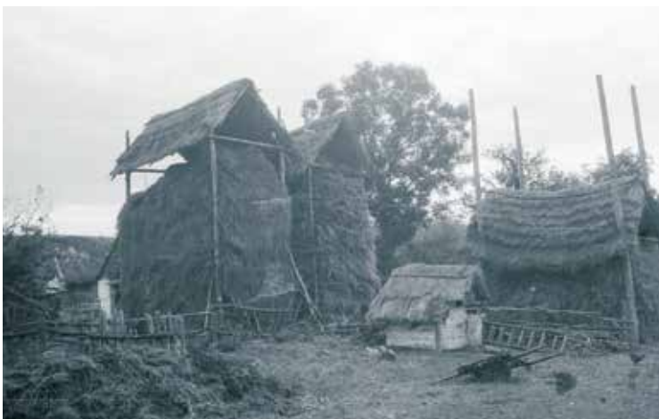
Solina (pow. leski), brogi z dwuspadowymi podnoszonymi dachami; fot. M. Łastówka 1965 r.
