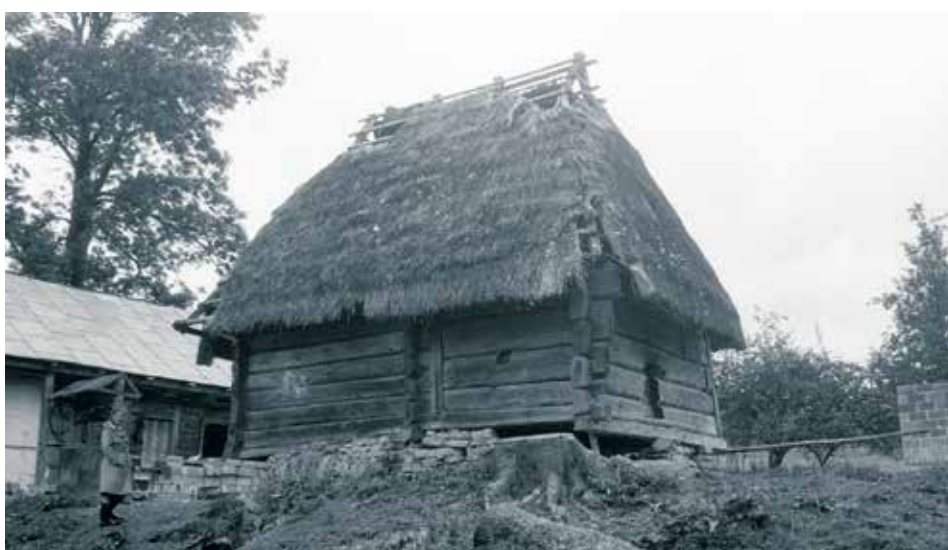
Bystre (pow. bieszczadzki), spichlerz zrębowy wiązany „na oblap” z dachem czterosпадowym poszywanym słomą; fot. H. Olszański 1975 r.
