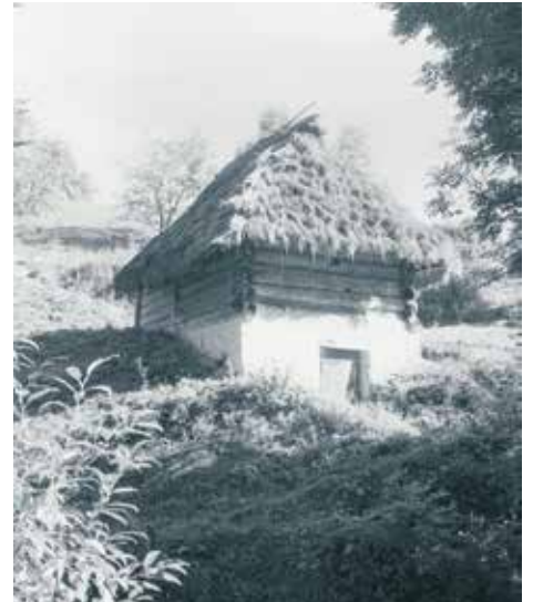
Rybne (pow. lesko), spichlerzy zrębowy z czterospadowym dachem nad murowaną piwniczką; fot. M. Łastówka 1965 r.
