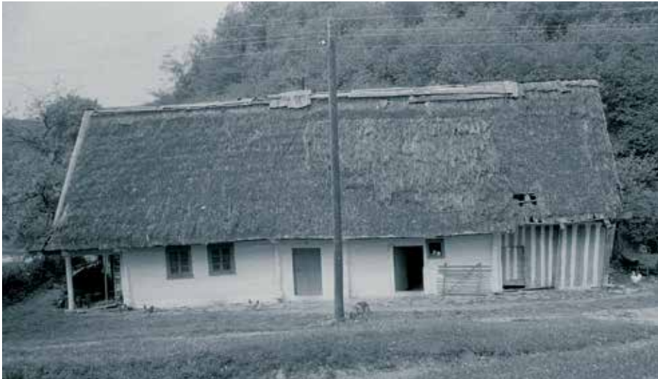
Roztoki Dolne (pow. leski), chata zrębowa z podcieniem narożnym nakryta dwuspadowym słomianym dachem; fot. W. Szulc 1966 r.
