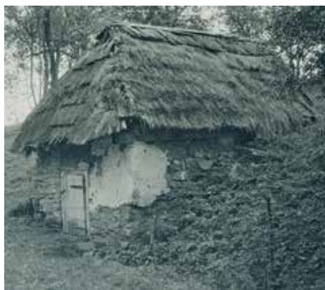
Dziurdziów (pow. leski), piwnica w stoku zbudowana z kamienia, nakryta czterospadowym dachem słomianym
