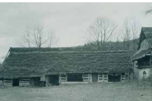
Skorodne (pow. bieszczadzki), chyża zrębową z 1922 r., część mieszkalna i gospodarcza pod jednym dachem, malowana w kolorze czerwono-brązowym z białymi stylkami belek i licem węglów; fot. L. Smoczkiewicz 1959 r.
