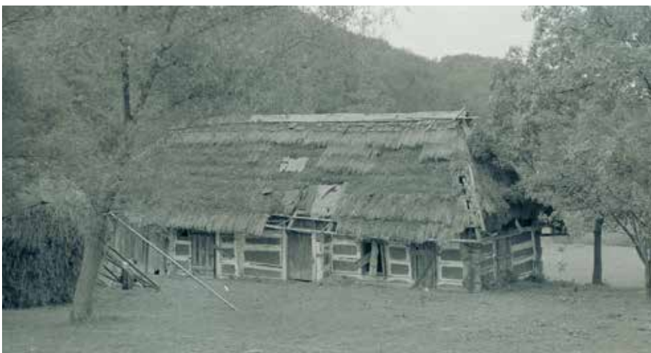
Czarna (pow. bieszczadzki), chata zrębowa z dachem czterospadowym poszywanym, słomą nakrywającym część gospodarczą i mieszkalną, zrąb malowany na czerwono-brązowy kolor, styk belek i lica węglów na biało; fot. J. Tur 1957 r.
